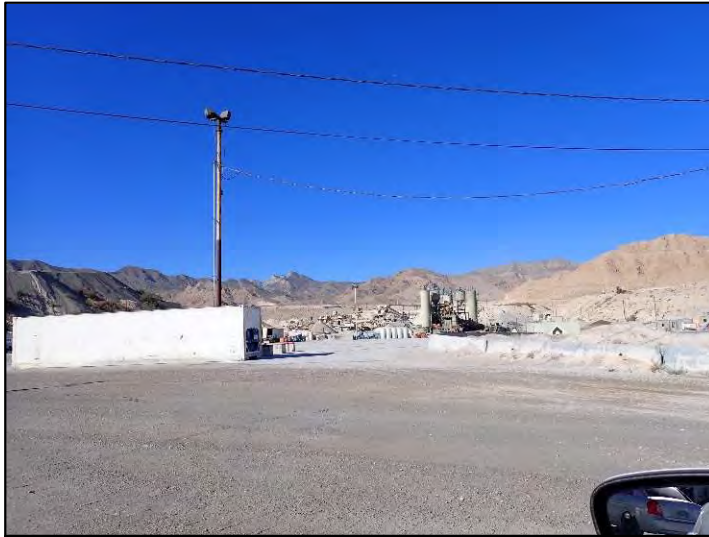
Nevada Ready Mix Lone Mountain.1.jpg
